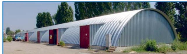
Во-первых, технология формовки цельной строительной панели полностью исключает применение сварных швов на всей длине арки. Поэтому она позволяет возводить сооружения без применения ферм, балок, перекрытий, гаек и болтов. За счет этого достигается полная герметичность швов арочных соединений. Выполненный по этой технологии ангар является одновременно прочным, устойчивым к коррозии и функциональным.
